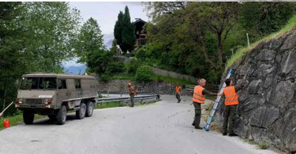
Instandhaltung WATTENBERGSTRASSE durch Kader TÜPI 2
